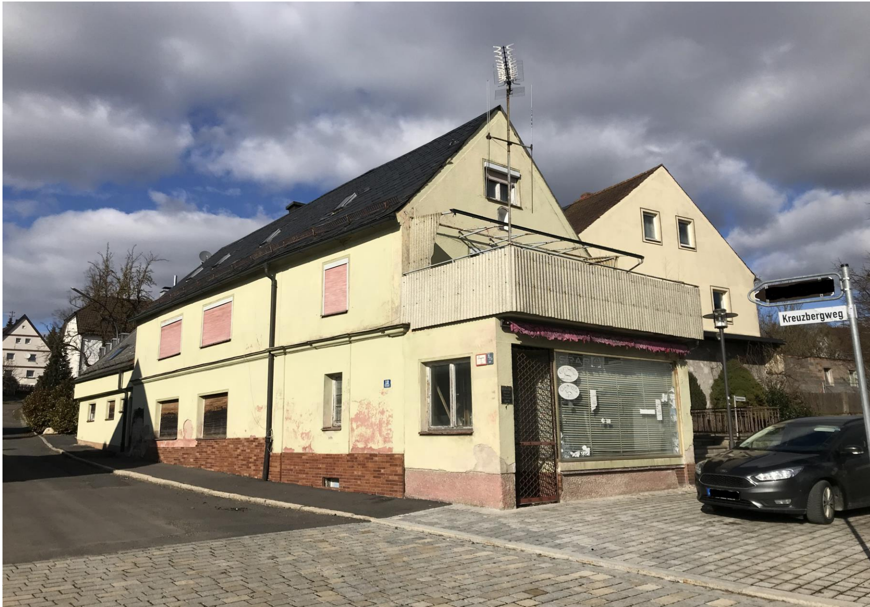
Wird dieses Jahr noch abgerissen: das ehem. Lebensmittelgeschäft am Kirchplatz (Härtl-Haus)
